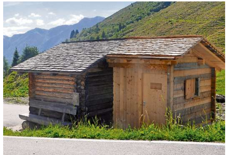
Die öffentliche WC-Anlage ist als Strickbau mit Schindeldach an das bestehende Warthäuschen angebaut. (ZVG)
